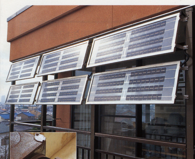
太陽光発電 窓にとりつけられたルーバー型ソーラーパネル。ひさしにもなり、一石二鳥だ。
